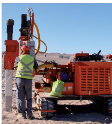
Εικόνα 12: Μηχάνημα τοποθέτησης πασσάλων
